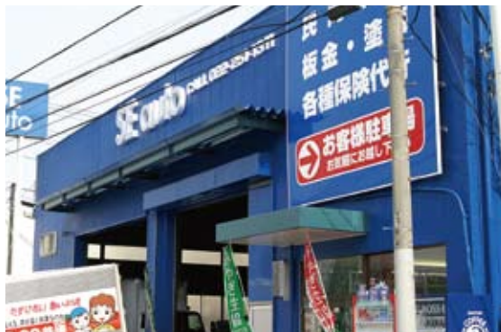
当社看板施工実績(センエンタクシー整備工場様)
